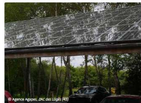
Gouttière intégrée à un linteau en bois qui souligne l'ombrière.
