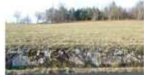
Soutènement d'un rebord de fossé en pierres de grès
