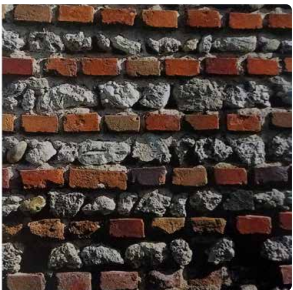
Murs composites en galets, briques et petites pierres de ramassage
