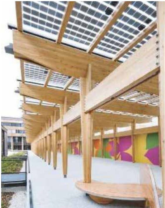
Des barbacanes sont intégrées à l’ombrière, dont l’eau collectée tombe dans une noue enherbée. Au sein d’un lycée, cette ombrière est un préau à multiples fonctions: protection (pluie, ombre), un lieu de vie (bancs et largeur confortable), une architecture en soi (qualité du dessin global, des poteaux fuselés, ajouement entre les cellules photovoltaïques pour faire pénétrer de la lumière), une surface de récupération des eaux pluviales (barbacanes et noue). Grenoble.
