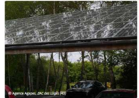
Gouttière intégrée à un linteau en bois qui souligne l'ombrière.
