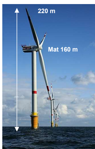
Eolienne en mer de 5 MW 160 m au rotor Diamètre des pales : 126 m
