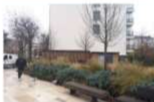
Intégration d'un poste de transformation en cœur urbain, adossé à un pignon d'immeuble. Habillage en lattes de bois verticales, ouvertures, couverture en bois acier sombre. Toitures publiques attenantes du même habitat. Montrouge (92).
