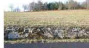
Soutènement d'un rebord de fosse en pierres de granite
